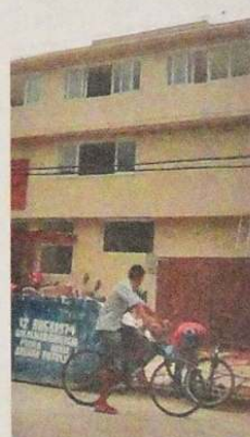
Casa em obras em Juqueí
